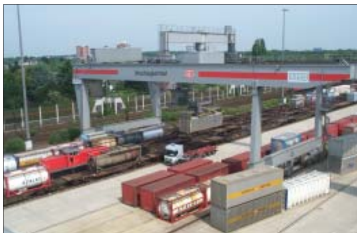
In ganz Deutschland plant, baut und betreibt die Deutsche Umschlaggesellschaft Schiene - Straße (DUSS) Terminals für den kombinierten Verkehr. Auch in Weiderting an der B 304 soll eine solche Anlage entstehen, um den Straßenverkehr zu entlasten.
